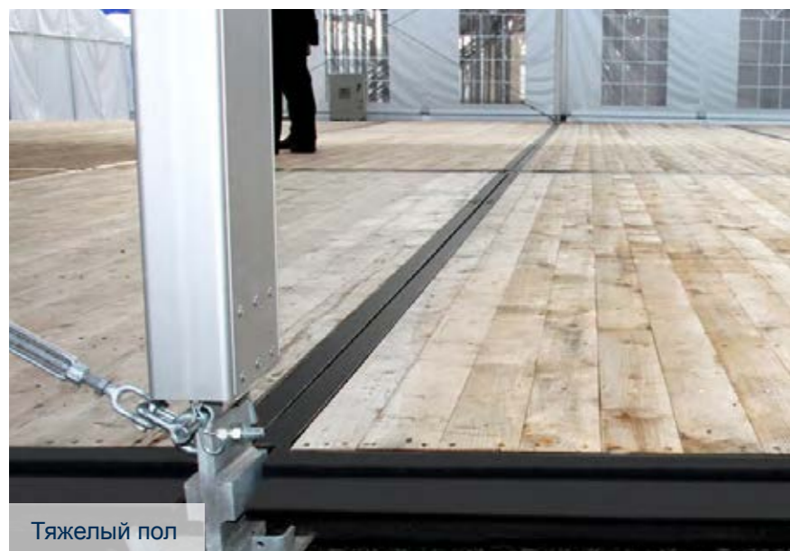
Деревянно-щитовой пол на металлическом каркасе
